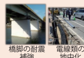
橋脚の耐震補強 電線類の地中化
